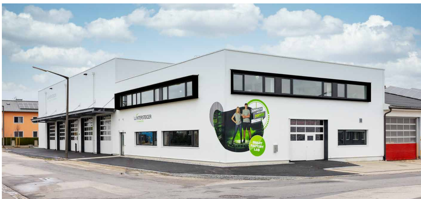
Neubau 2022: Neue Lehrwerkstätte „Smart Factory Lab“ und Technik & Service Seedmech
