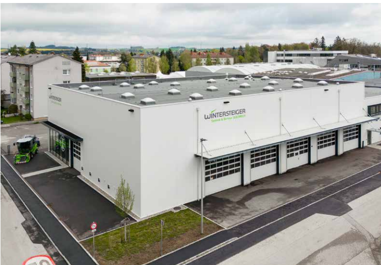
Neubau 2021/2022: Technik & Service Seedmech
